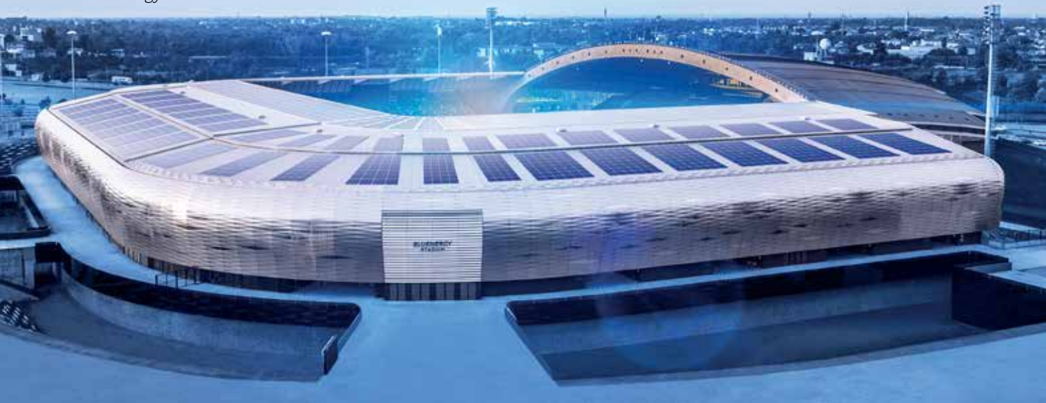
Il progetto fotovoltaico del Bluenergy Stadium di Udine
